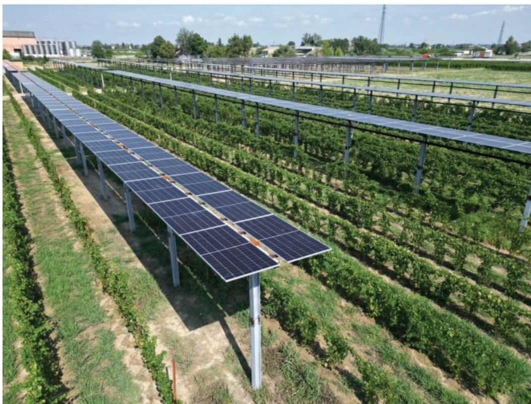
Figura 3 Esempio simile delle file di moduli di un impianto agrivoltaico.
